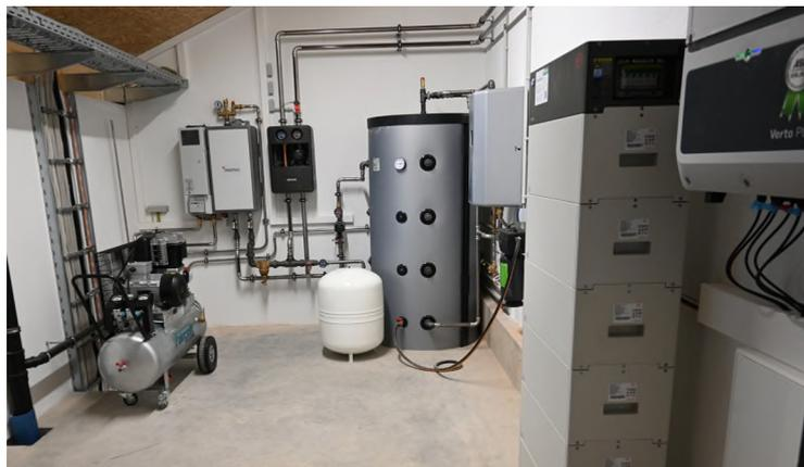
Im **modernen Technikraum** im Obergeschoss befindet sich eine Photovoltaikanlage mit Speicher, über welchen sich das Haus für Wasser- und Musik sowie das neue Bauhofgebäude zu einem Großteil mit selbst erzeugtem Strom versorgen lässt. Auch die Übergabestation für die Fernwärme ist dort – Bauhof, Haus für Wasser und Musik sowie Feuerwehrhaus werden vom Heizwerk Marquartstein mit Fernwärme beliefert.
