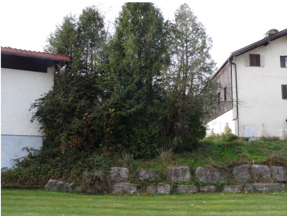
Abbildung 4: Teil einer Trockensteinmauer, die sich von Nord nach Süd mittig durch das Plangebiet zieht, darüber ein Thujengehölz.
