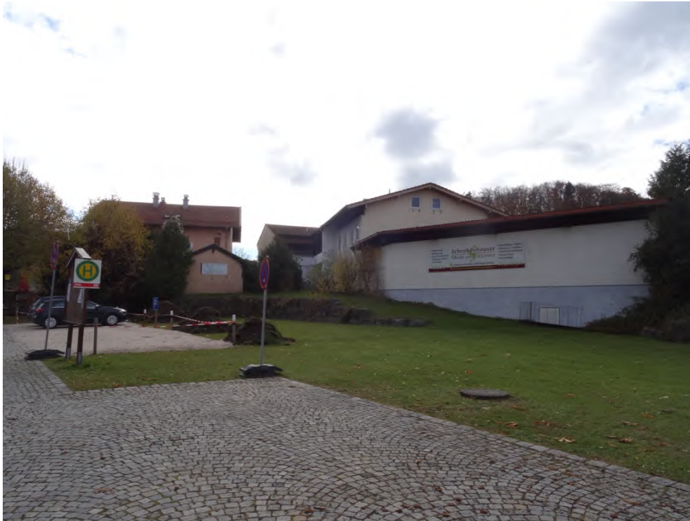
Abbildung 3: Östlicher Bereich des Plangebietes mit dem leerstehenden Gebäudekomplex (rechts), einer durch eine Trockensteinmauer abgetrennten Wiesenfläche und Parkplätzen.
