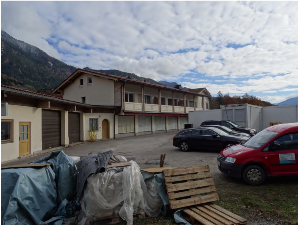
Abbildung 7: Ostfassade des Gebäudekomplexes mit davor liegenden Parkflächen.
