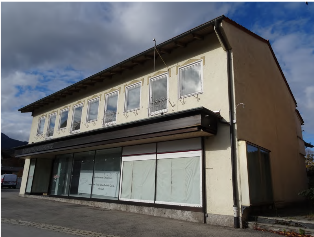
Abbildung 6: Südfassade des Gebäudekomplexes, zur Schlechinger Straße hin.
